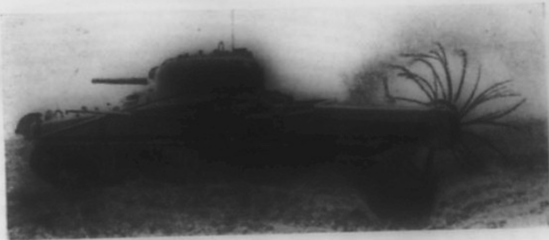
Minenräumgerät auf amerik. Panzerkampfwagen „Sherman“
