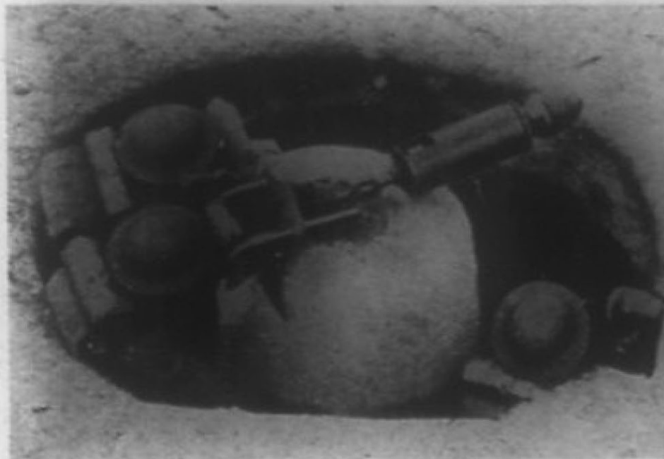
„Spigot Mortar“ fest eingebaut auf Betonsockel
